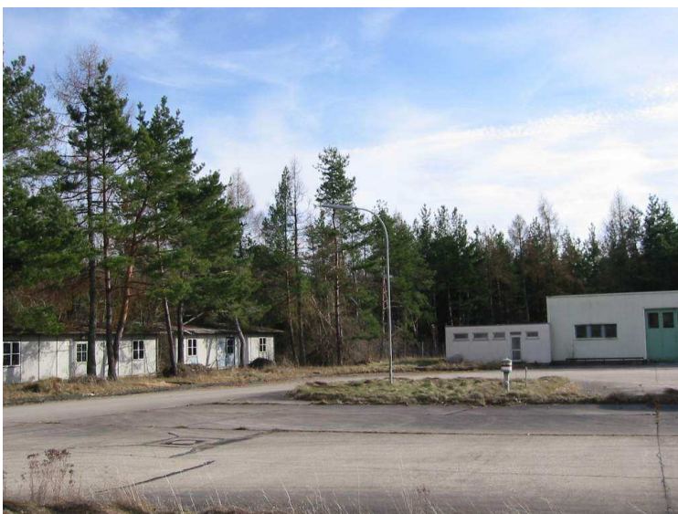
Lagergebäude und Waldrand im Süden des Gebiets
